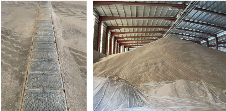
Foto. Detall canal ventilació magatzem. Dreta, ordi tapat per tractament amb fosfur d'alumini
