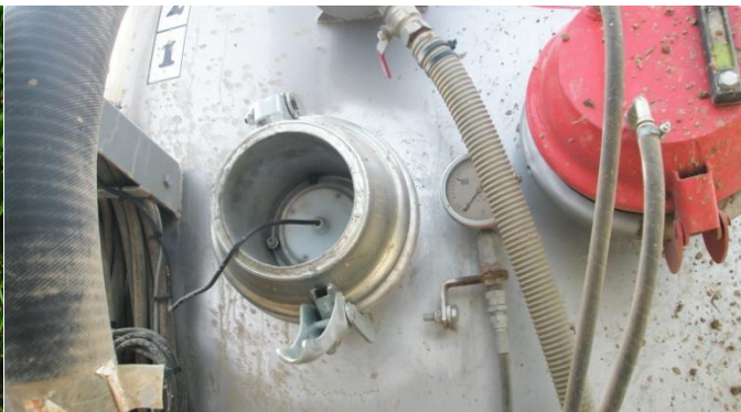
Foto 2: Conductímetre automàtic instal·lat en cuba
